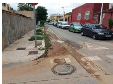
EL FIRME DE LA CALZADA PRESENTA HUNDIMIENTOS, ESTOS ESTAN GENERANDO HUNDIMIENTOS DE LA ACERA TAMBIEN. Se trata de una calle de las paralelas a la avenida de la paz, al igual que el resto de paralelas se propone, se propone la creación de dos aceras de 2,30 donde se respetarán los alcorques existentes y se colocarán las farolas entre alcorques para siempre dejar los 1,20 de paso. Con el fin de unificar todas las paralelas de la zona de los Casetes.
